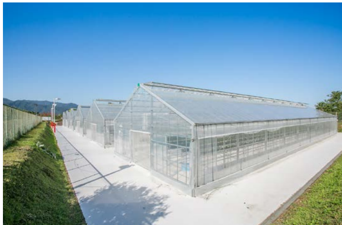
いちごハウス外観
